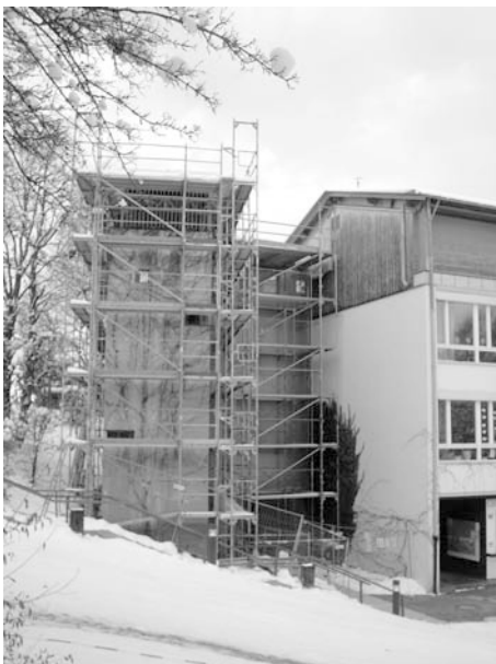
Sanierungsmaßnahmen am Treppenturm der Grundschule. Foto: Andrea Knauder
