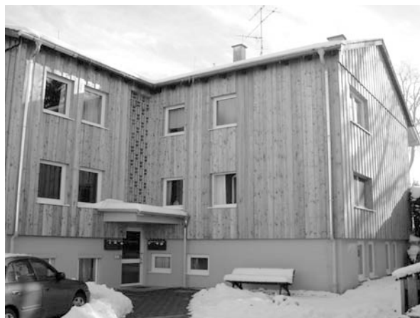
Sanierte Aussenfassade am Gemeindehaus in der Bergstrasse
