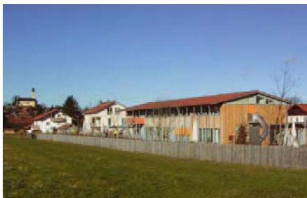
Kindergarten mit Familienzentrum an der Käthe-Kruse-Strasse in Hohenschäftlarn
